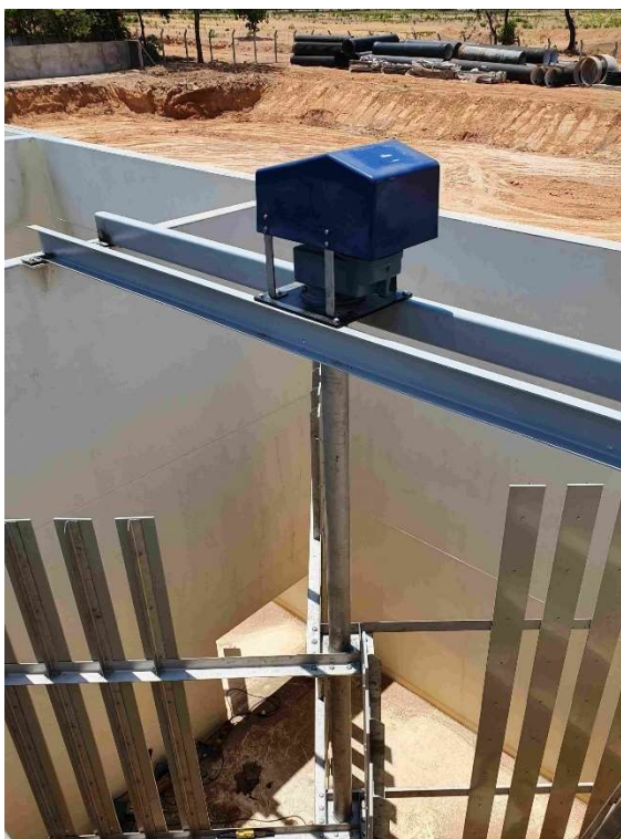
Figura 03. Exemplo de uma Câmara de um Floculador
