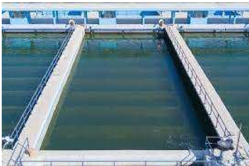
Figura 05. Exemplo de uma Câmara de um Filtro Descendente
