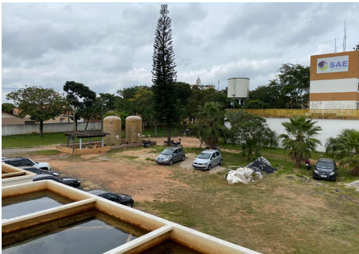
Figura 07. : Área junto ETA existente, com possibilidade de instalação da nova ETA
